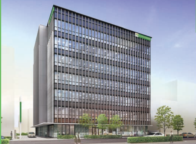
■新本店建設中(平成26年11月1期棟完成予定)
